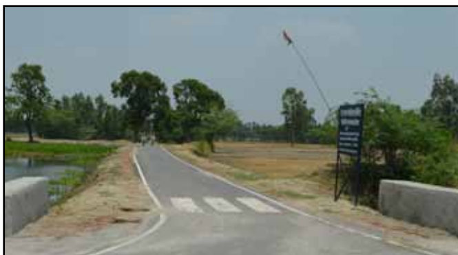
बरौलिया कोरवा में पक्की सड़क का निर्माण
